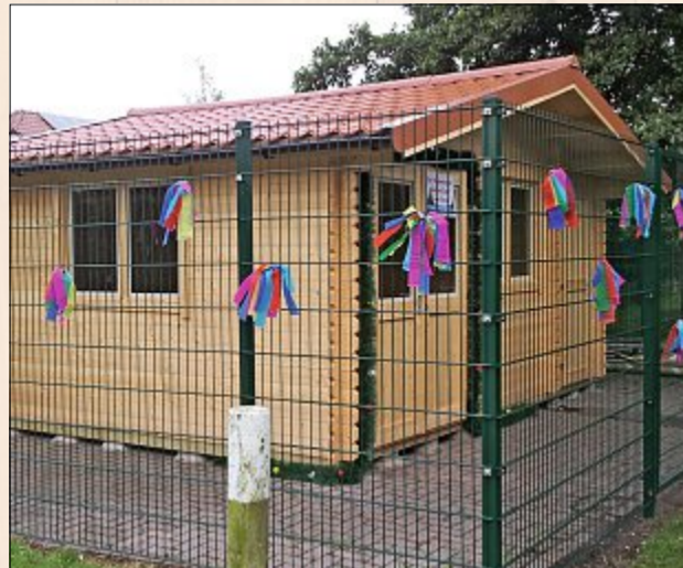
Bereits zum Richtfest bekam das Blockhaus einen Ehrenbogen.
